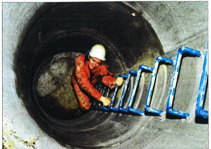
Der Einstiegsschacht führt 3,6 m in die Tiefe.
